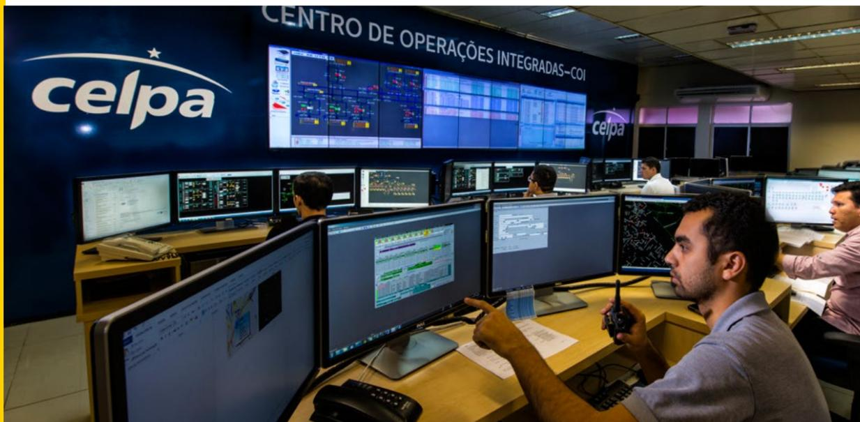
Cemar e Celpa investem em alta tecnologia, como no Centro de Operações Integradas (COI), cujos operadores acompanham integralmente o funcionamento de toda a estrutura de distribuição de energia elétrica (postes, transformadores ou subestações). Qualquer problema de carga ou interrupção de fornecimento de energia é sinalizado no COI, pois seu sistema de georreferenciamento avisa, imediatamente, na tela dos computadores. Cada Estado tem o seu Centro de Operações.
